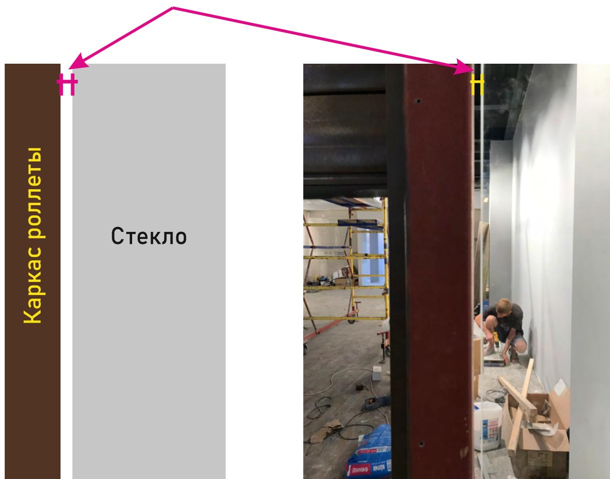
Толщина композитного короба обшивки роллеты не должна быть менее - 150мм
